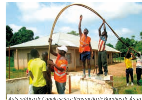
Aula prática de Canalização e Reparação de Bombas de Água.
