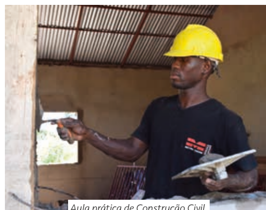
Aula prática de Construção Civil.
