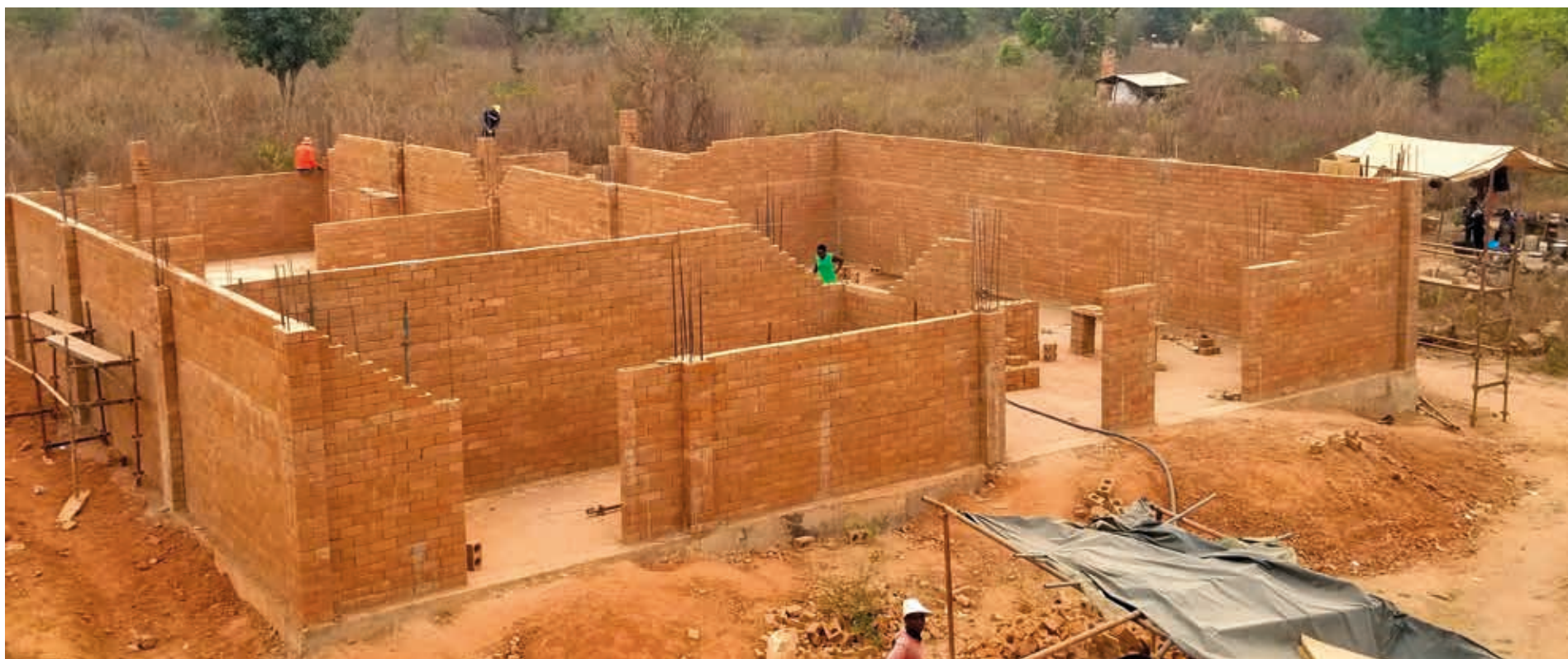
Construção do Centro de Processamento de Caju.
